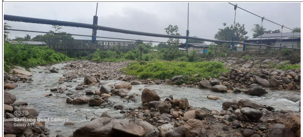
FIGURA N°02- PARTE DEL TRAMO QUE EN SU MAYORIA SE ENCUENTRA DESPRENDIENDO DEL TALUD Y COLMATADO CON MATERIAL BOLONERIA EXPONIENDO A LAS VIVIENDAS DEL SECTOR SAN JOSÉ DE JAPAIME
